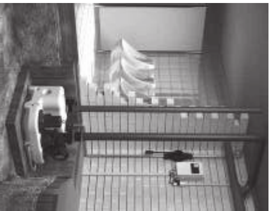
Рис. 96 Пример установки Multilift MD в прямике в подвальном помещении здания
