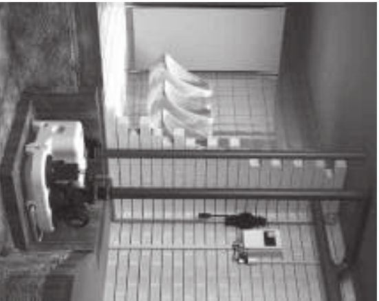
Рис. 100 Пример установки Multilift MLD в приямке в подвальном помещении здания
