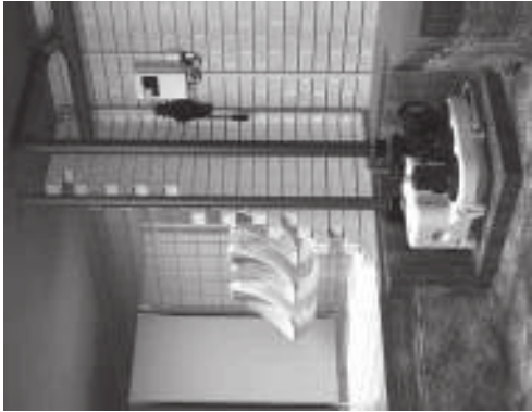
Рис. 91 Пример установки Multilift MOG в прямке в подвальном помещении здания
