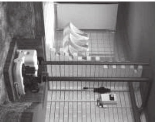
Рис. 87 Пример установки Multilift M в приватке в подвальном помещении здания
