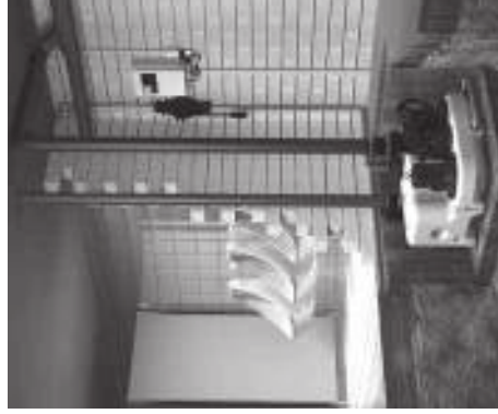
Рис. 104 Пример установки Multilift MDG в прямке в подвальном помещении здания
